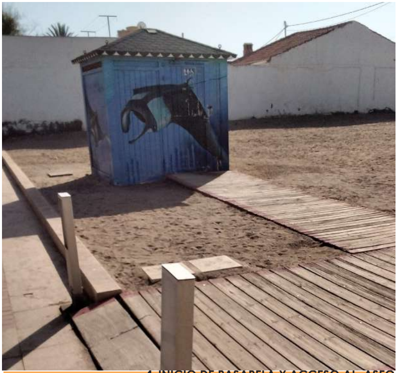
4_INICIO DE PASARELA Y ACCESO AL ASEO
