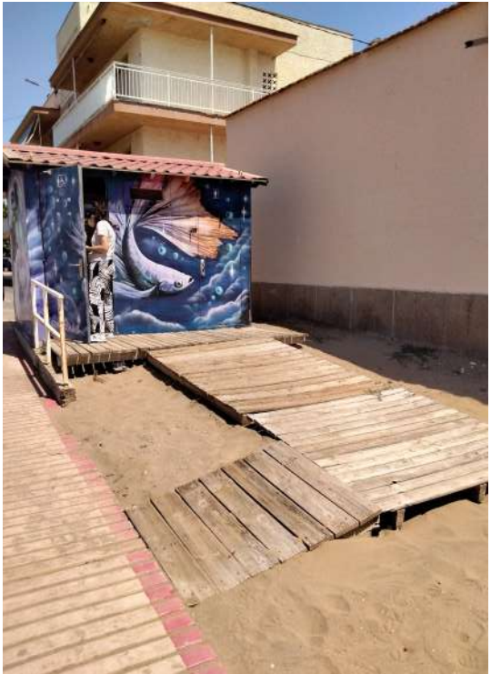
4_ ACCESO AL ASEO
