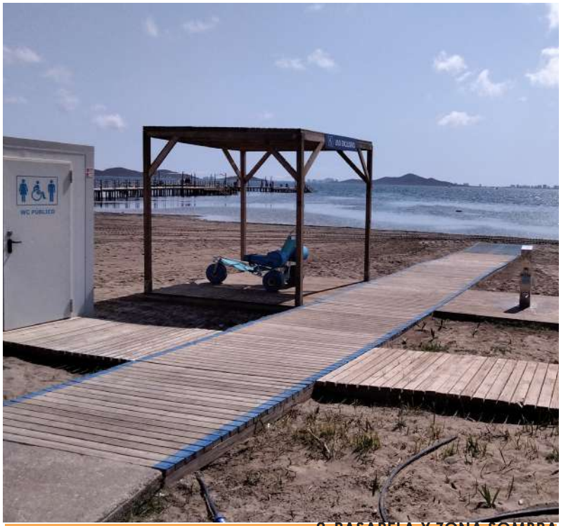
2_PASARELA Y ZONA SOMBRA
