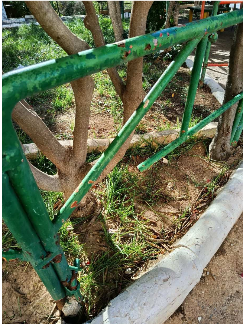
-Imagen de una pequeña muestra, donde se observa estructuras de hierro oxidados y rotos
